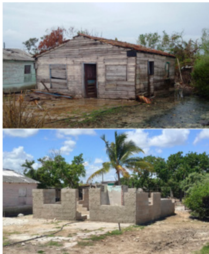
Figura 4. De madera a bloque de hormigón: recuperación de una vivienda que resistió al huracán Irma. Fuente: González G., 2017.
